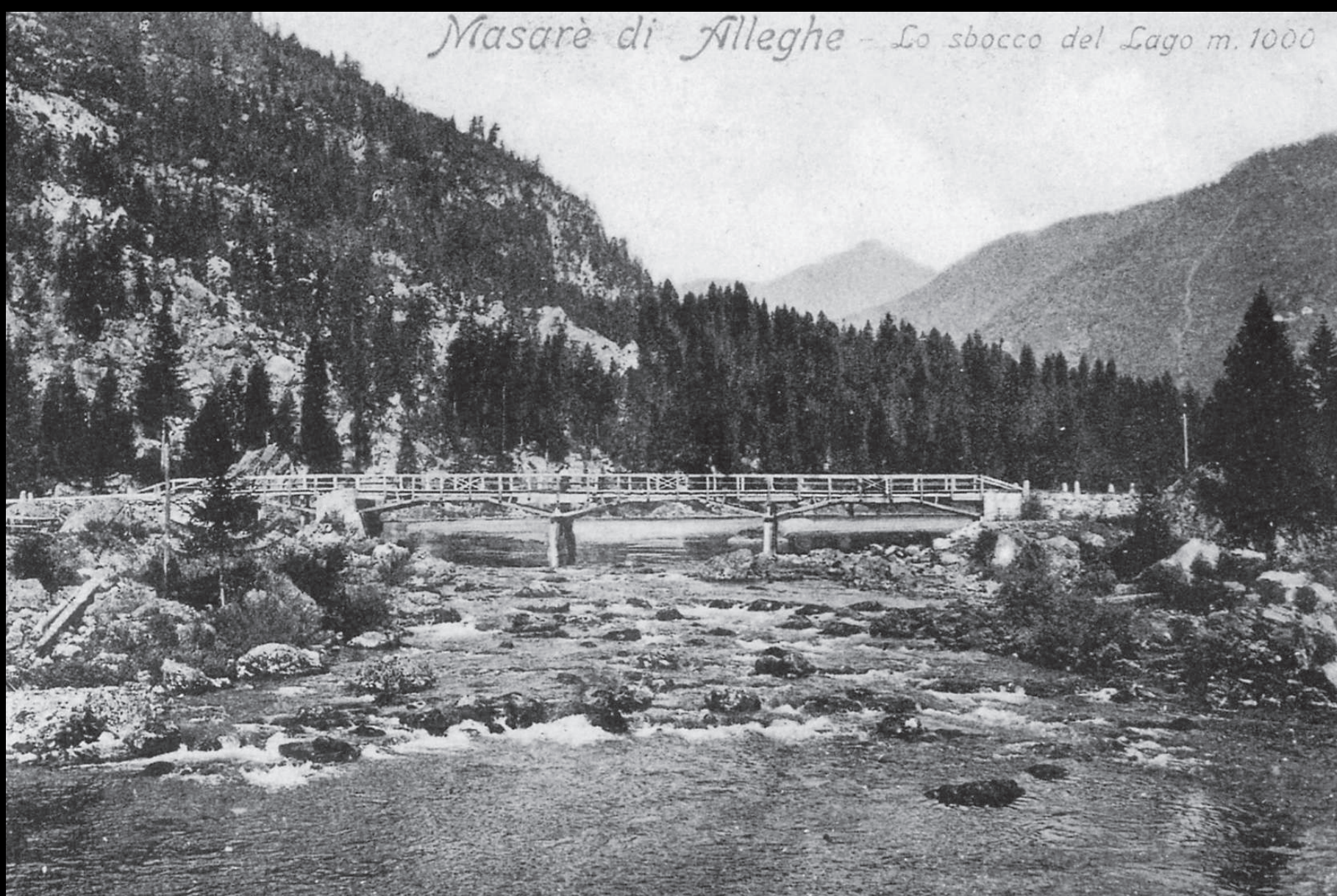
Il ponte di Masarè all'inizio del '900 (foto Avi, raccolta E. Pollazzon)
